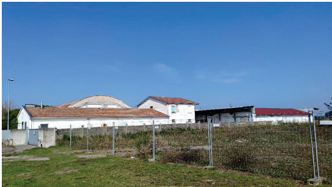
Stabilimento Ex Sala (Prima Della Demolizione)
