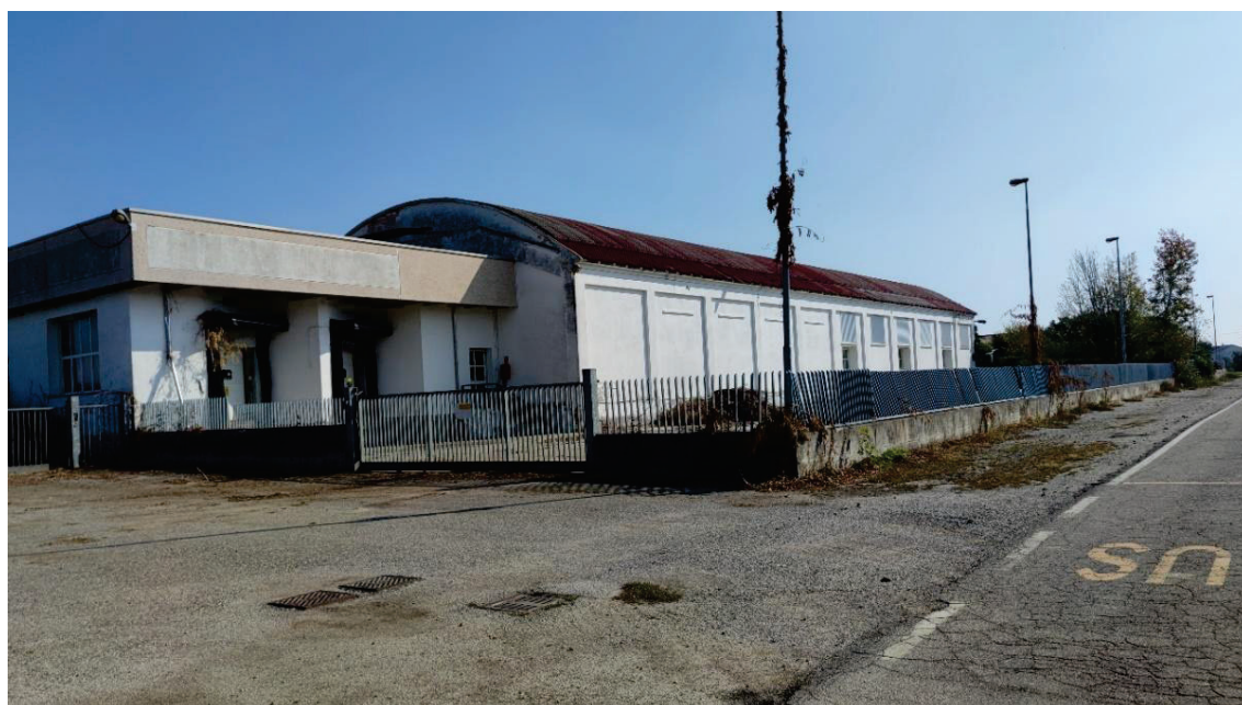
Stabilimento Ex Sala (Prima Della Demolizione)
