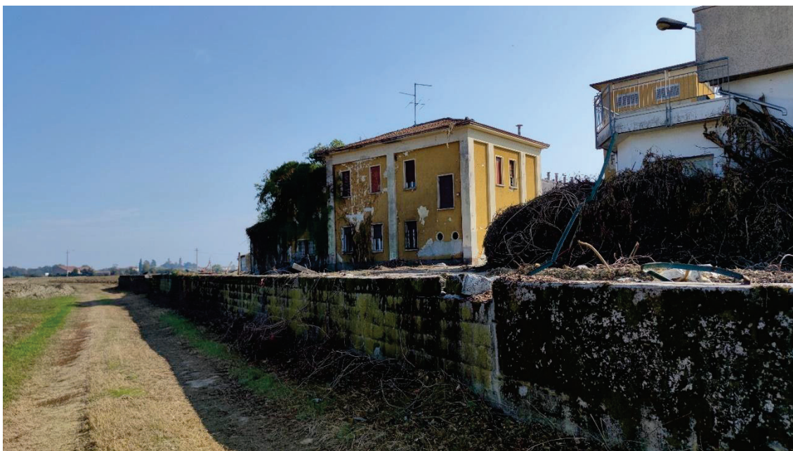
Stabilimento Ex Sala (Prima Della Demolizione)
