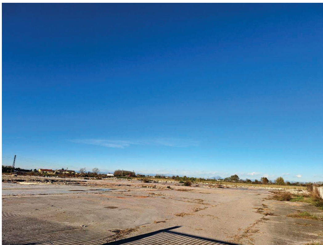
Area Stabilimento Ex Sala (Dopo Demolizione Fabbricati)
