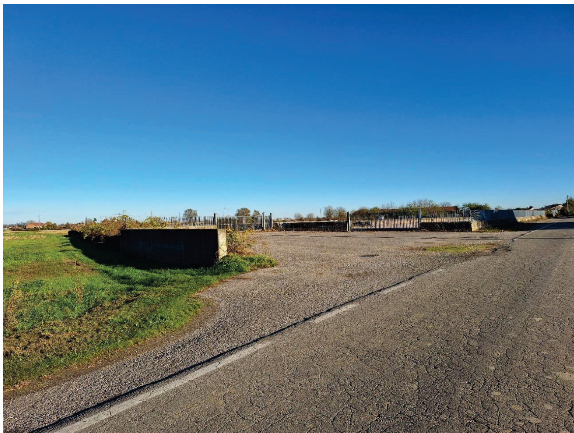
Area stabilimento ex Sala (dopo demolizione fabbricati)
